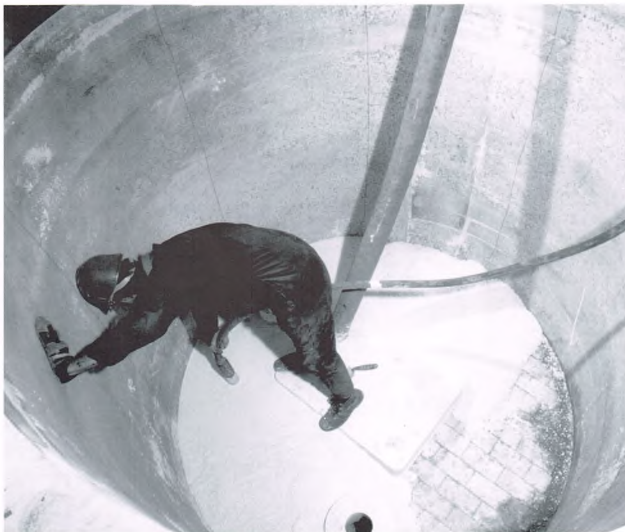
Exemple d'installation de nos produits dans une poche de transport d'acier liquide. Après coulage et décoffrage des parois verticales, le technicien, debout sur la dalle d'impact préfabriquée, installe par pompage le revêtement du fond de la poche en béton réfractaire.
