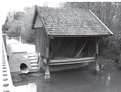
BAGNEUX, près du pont de l'église (voir le moulinet de relevage du tablier)
