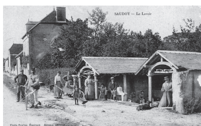
SAUDOY, à partir de l'emplacement actuel du transformateur électrique, CPA
