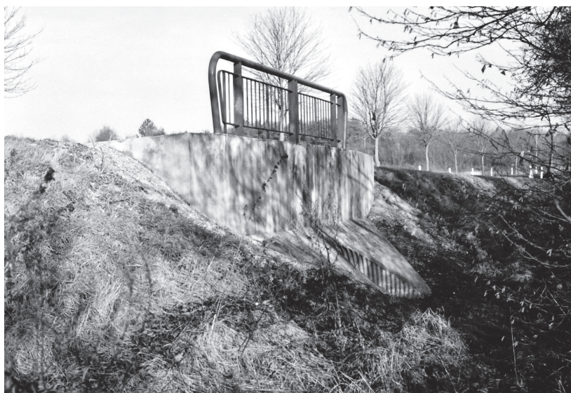
doc.3 Pont sur la route D5 de Fère à Châlons.
