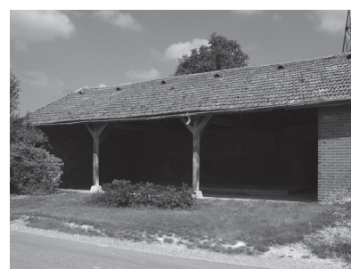
CELLE-SOUS-CHANTEMERLE, au pied de l'éolienne
