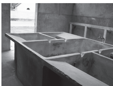
LES GRÈVES, hameau de Bagneux, bacs en béton intacts
