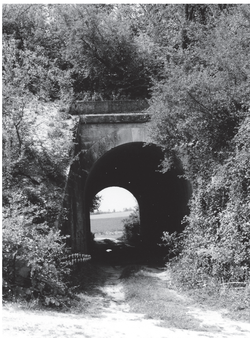
doc.5 Pont sous la voie ferrée de Fère à Sommessous.
