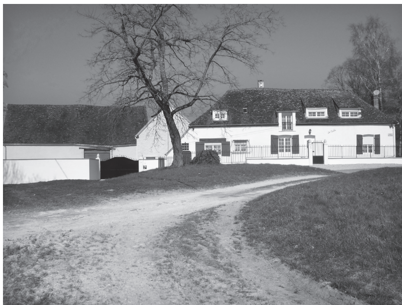
L'état actuel de la parcelle 263 : la place de la tuilerie et la maison du tuilier.
