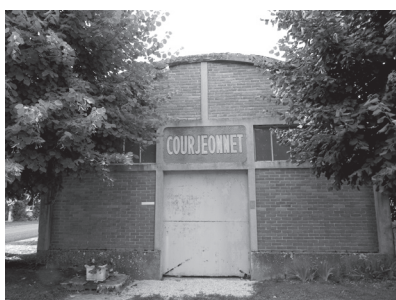
COURJEONNET, intéressant mélange d'une structure brique et béton
