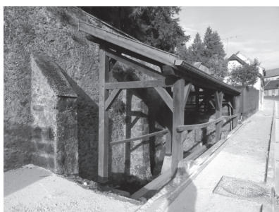
MONTMORT, le même, sauf la restauration qui a inversé la pente du toit, et le formidable réhaussement de la voie publique par les travaux actuels
