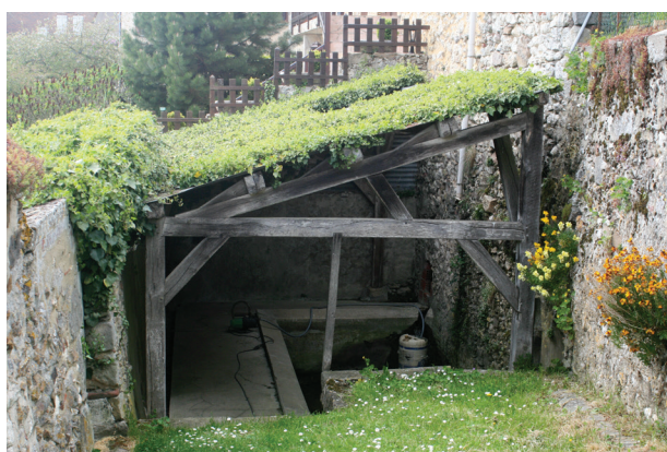
doc.9 Lavoire de la ruelle du Puyat
