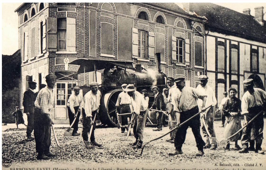
doc.1 À Barbonne, place de la Liberté, réfection de la route par les cantonniers. Ils utiliseront l'imposant rouleau pour parfaire leur travail.
