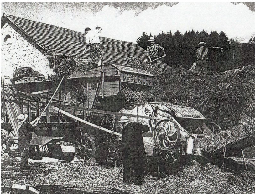
doc.20 Le battage à la ferme avec presse à balles de petits formats à la suite
