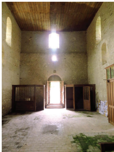
Vue du revers de la façade Ouest
