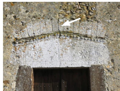
Vue du linteau roman avec arc de décharge
