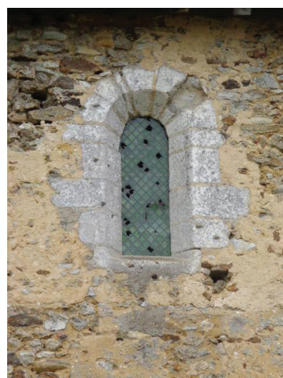
Fenêtre romane avec chaînage en harpe
