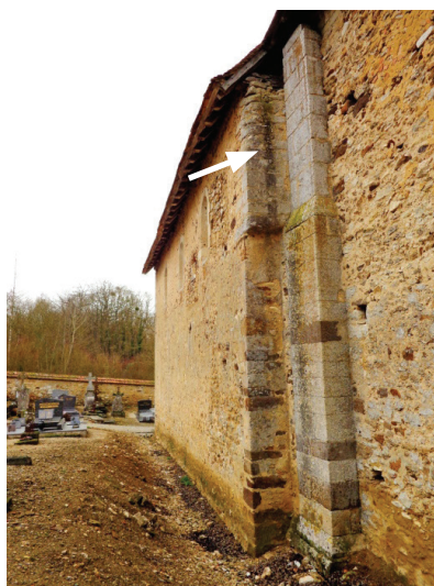
Vue générale du côté Sud avec décrochement
