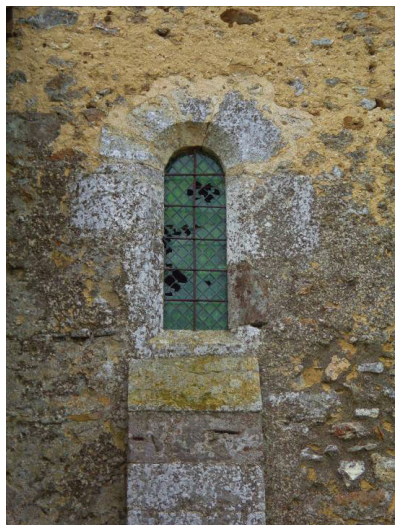
Fenêtre en arc en plein-cintre de la travée sous clocher
