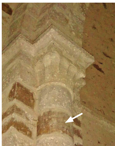
Chapiteaux feuillagés agrémentant une colonne engagée dont la bichromie est obtenue par l'usage de grès ferrugineux (flèches)
