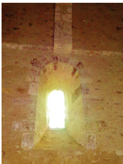
Fenêtre en plein-cintre avec emploi de grés ferrugineux
