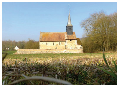
Vue générale, côté Sud
