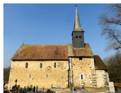
Vue générale de la nef
