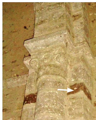
Chapiteaux feuillagés agrémentant une colonne engagée dont la bichromie est obtenue par l'usage de grès ferrugineux (flèches)
