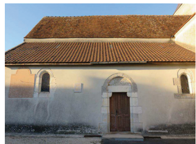
Vue du bas-côté Sud
