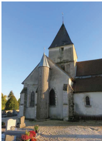
Tourselle du transept Nord
