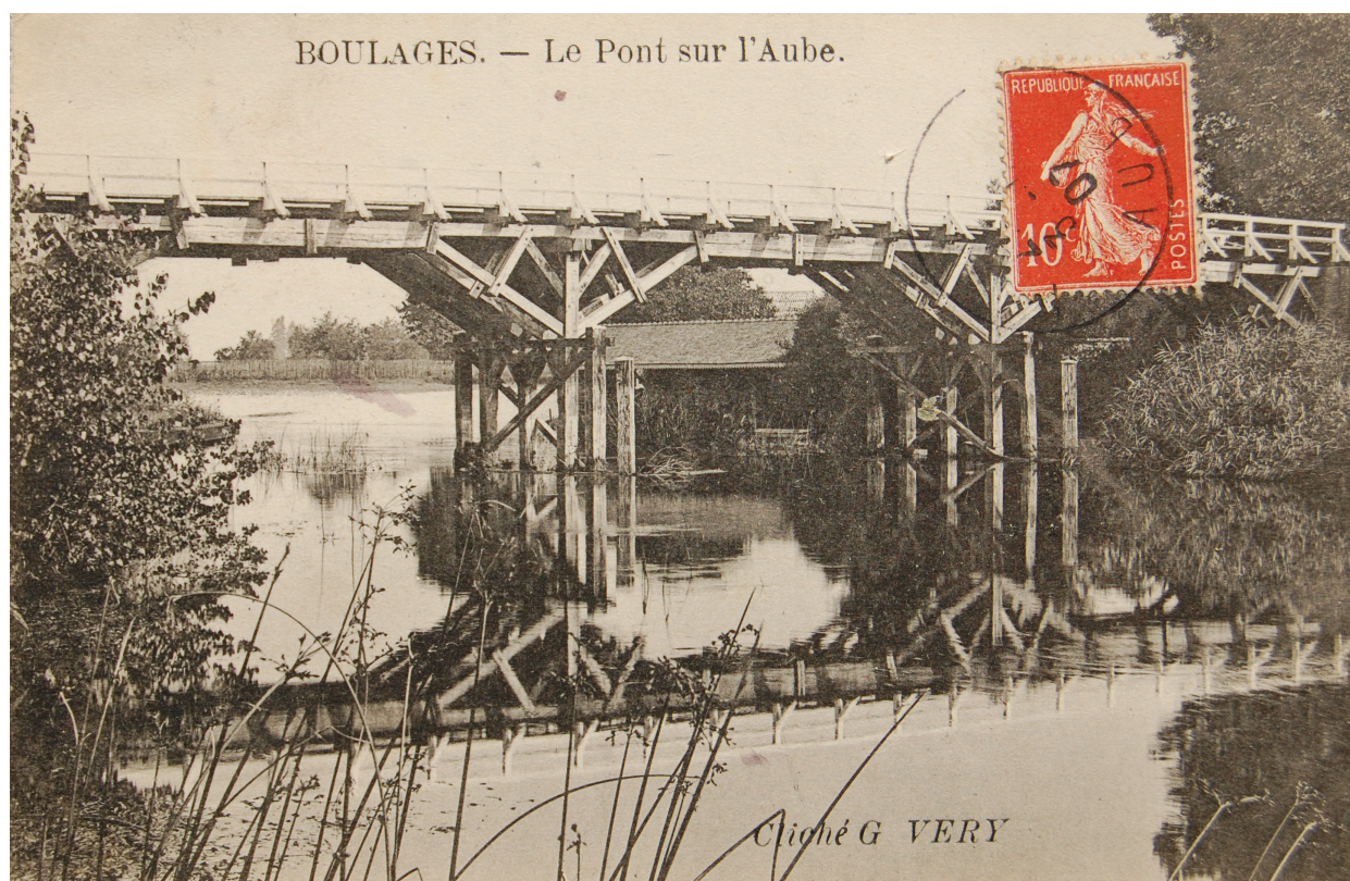
doc.3 Le pont sur l'Aube à Boulages
