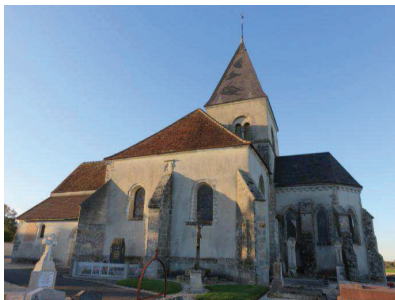
Vue du côté Sud de l'église
