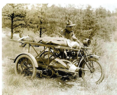
doc.12 Side-car Indian transformé pour le transport de 2 blessés.
