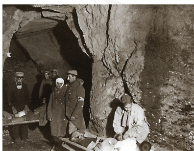
doc.1 Poste de secours installé dans une creute
