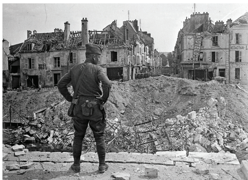
doc.2 Soldat devant les ruines du pont dynamité de Château-Thierry.
